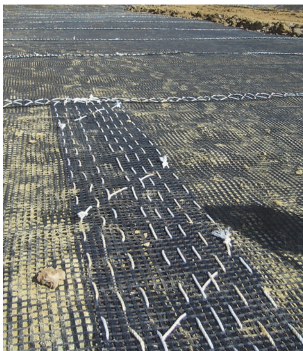
Figure 6. Assemblage par cordelette de 2 lés de géogrille.
