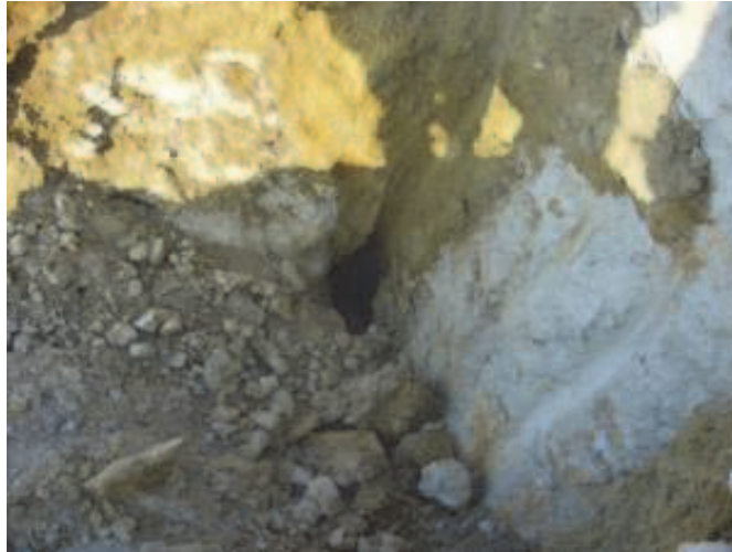
Figure 3. Photographie du sondage SD2 ouvert à la pelle mécanique.
